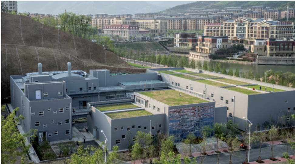
Blick auf die Referenzanlage in Qingdao.
