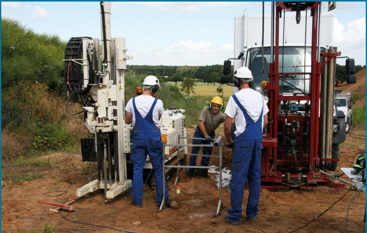
Einsatz des Direct Push-Verfahrens zur Untergrunderkundung
