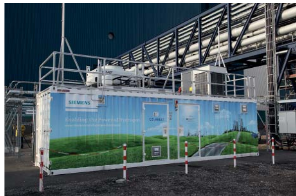
Abbildung 15: Prototyp des Siemens-Elektrolyseurs mit 0,3 MW Leistungsspitze am RWE-Standort Niederaußem, nahe Köln
