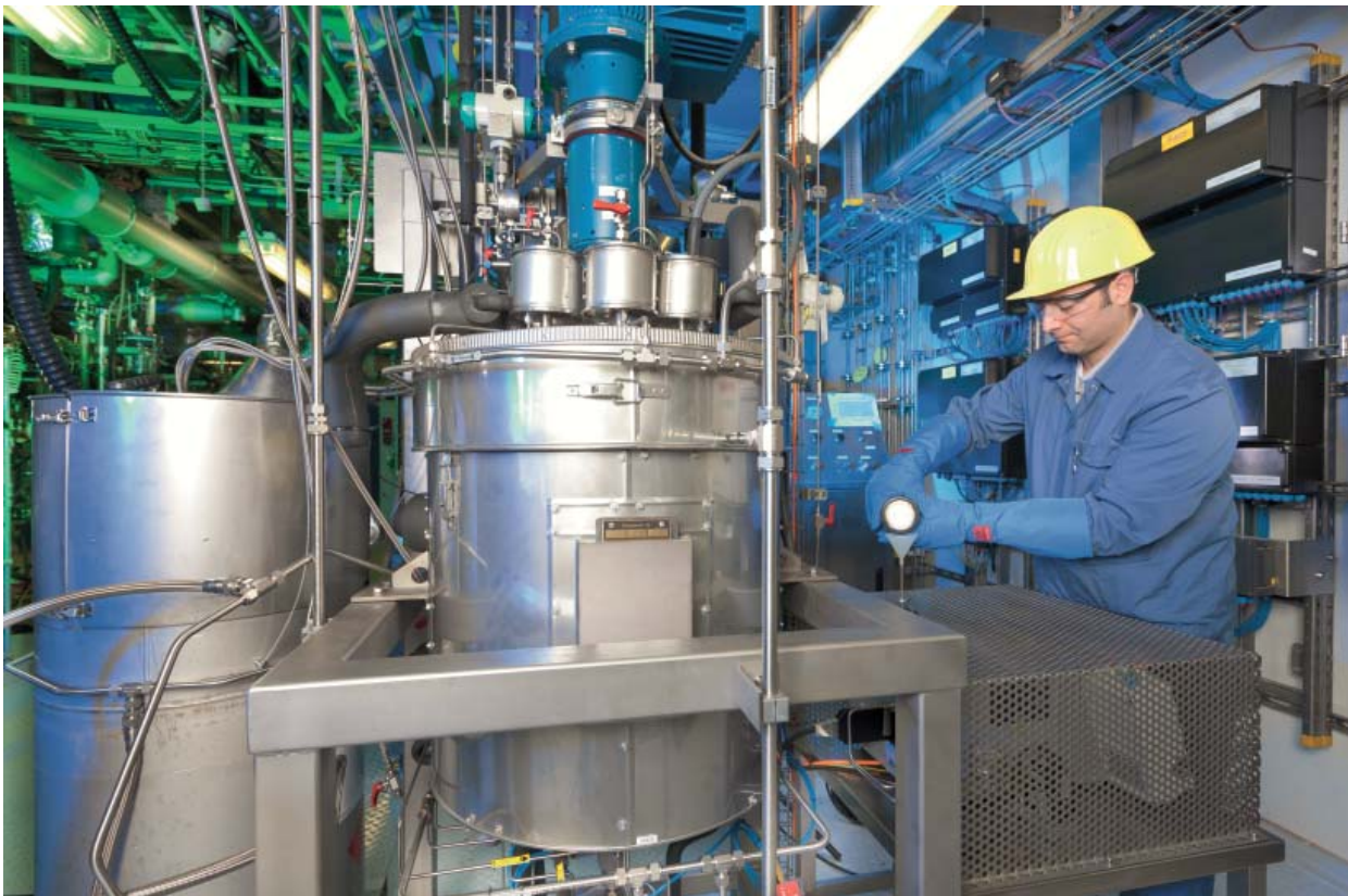
Abbildung 1: Pilotanlage in Leverkusen
