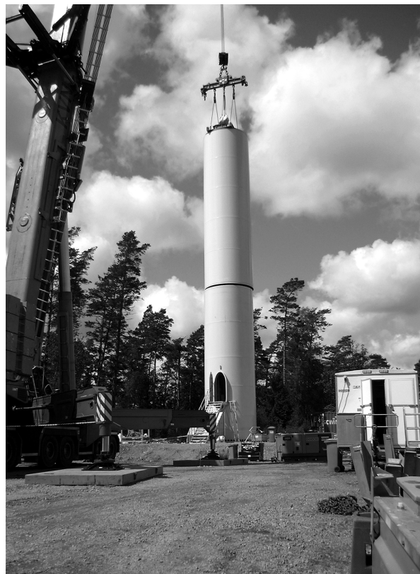
Abbildung 1: Montage von Turmsegmenten bei der Errichtung einer Windenergieanlage vom Typ GE 2,75-103 im Windpark Askombjär bei Falkenberg/Schweden
