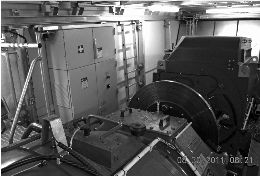
Abbildung 2: Blick auf Getriebe, Bremse und Generator einer im Service befindlichen, angehaltenen WEA vom Typ Nordex N100. Zu Wartungszwecken wurde der Funkenschutz der Bremsscheibe demontiert.
